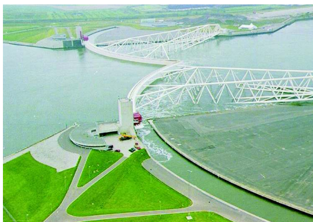
Bild 2: Maeslant-Sperrwerk bei Rotterdam
